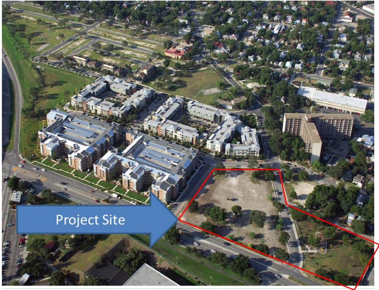
Victoria Commons Project Site
