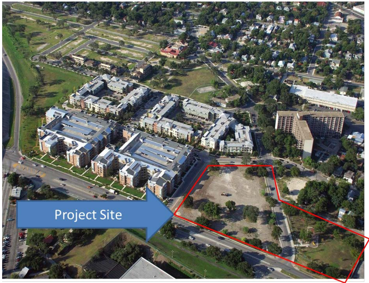
Victoria Commons Project Site
