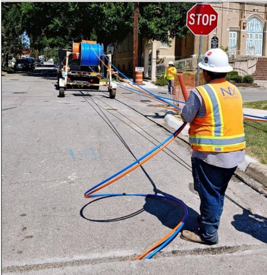
Fiber Conduit Installation
